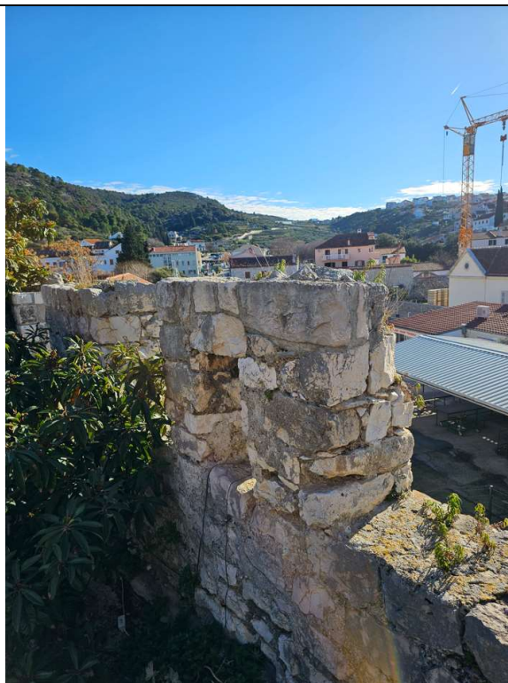
Slika 3-7 Kruna 19 – pogled iznutra
