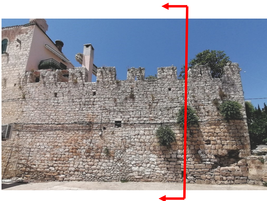
Slika 3.2. Pogled na južni zid s prostora tržnice
