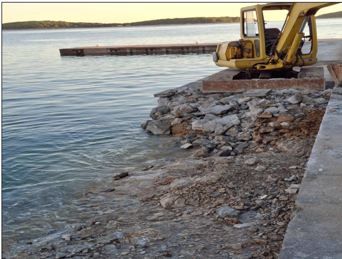
Slika br. 5: Radovi na sanaciji plivališta Bonj
